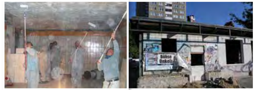
Es gab eine Menge zu tun: Wände wurden eingerissen, Kacheln abgesprengt, Böden wurden gegossen, Decken gestrichen, Wände eingezogen, Rohre gelegt – und überall waren die Jugendlichen mit dabei.
